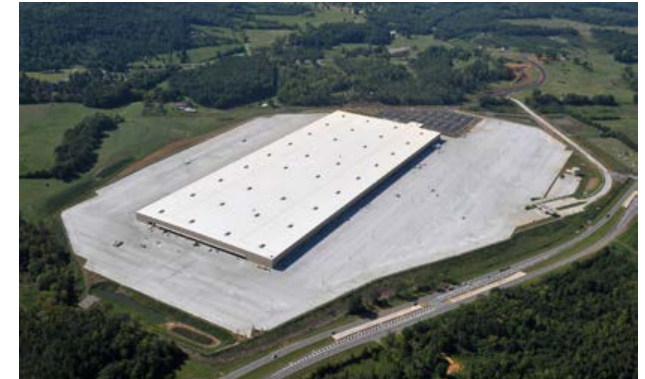
Centro de Distribución de Lowe's
